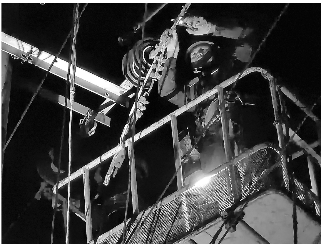
奋战保电第一线的电力人 乐山电力股份有限公司供图
