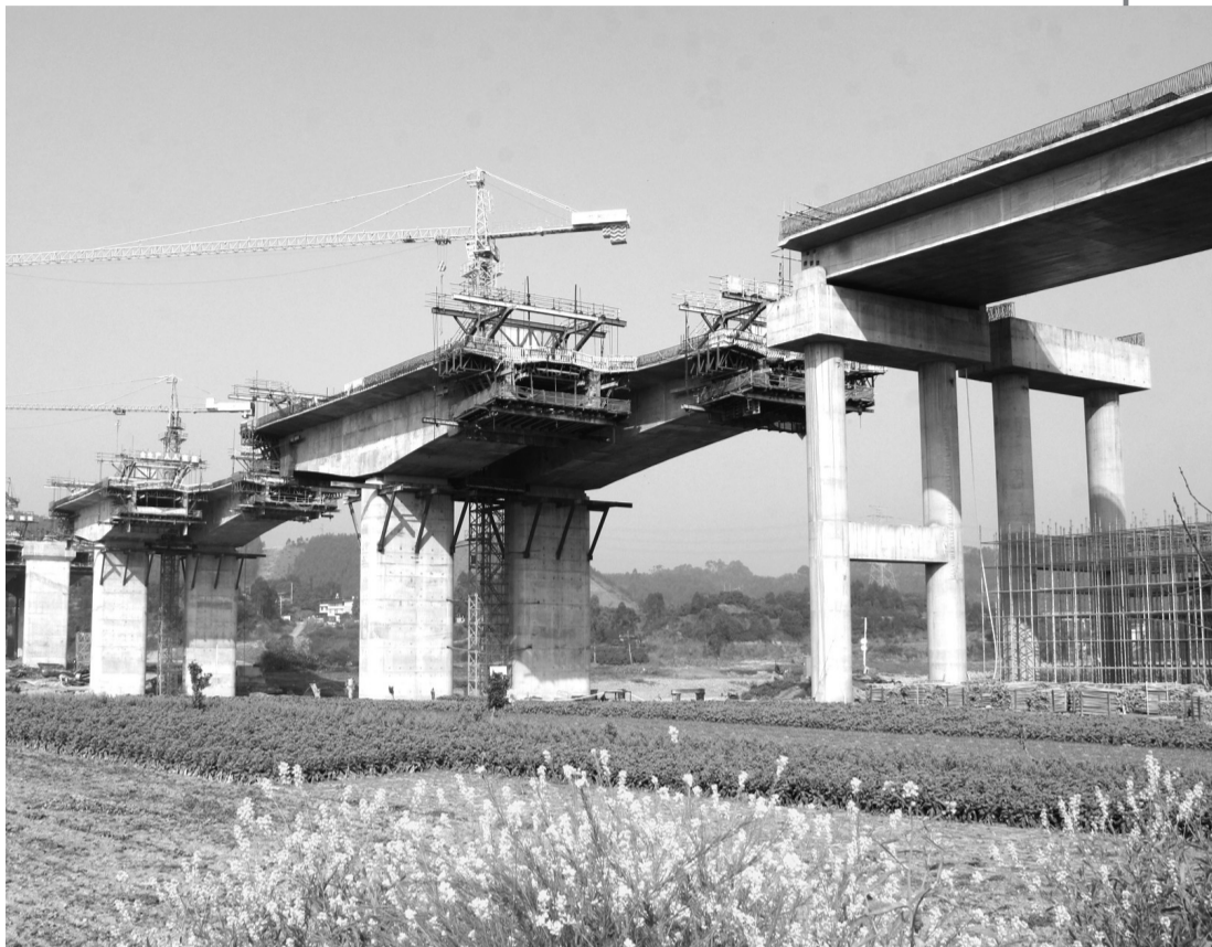
正在建设中的省道308线改线工程漩水沱岷江特大桥
