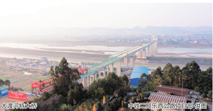
大渡河特大桥
