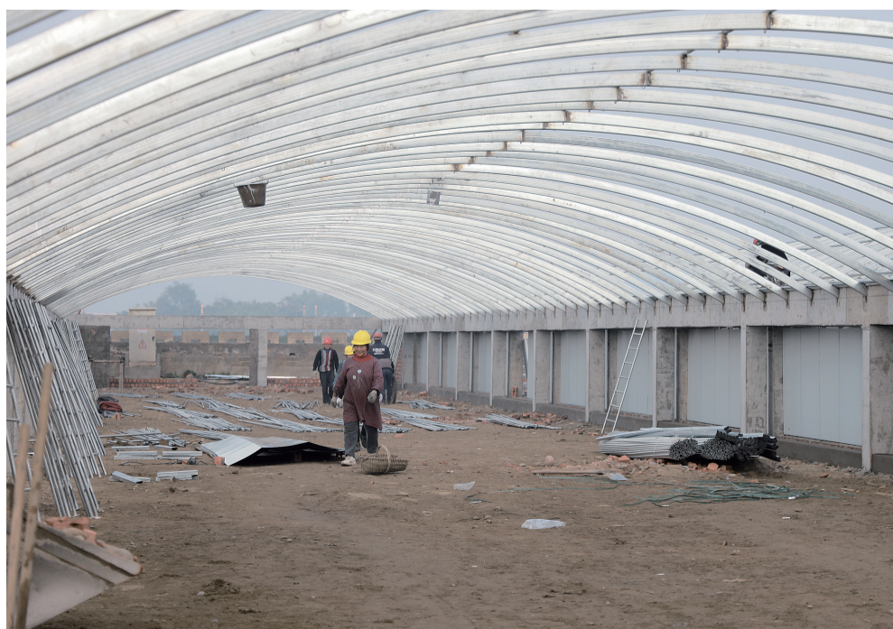
项目建设现场
