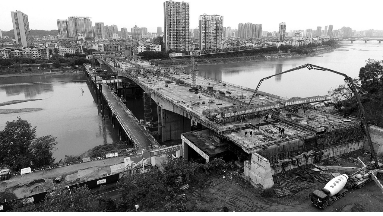
项目建设现场
