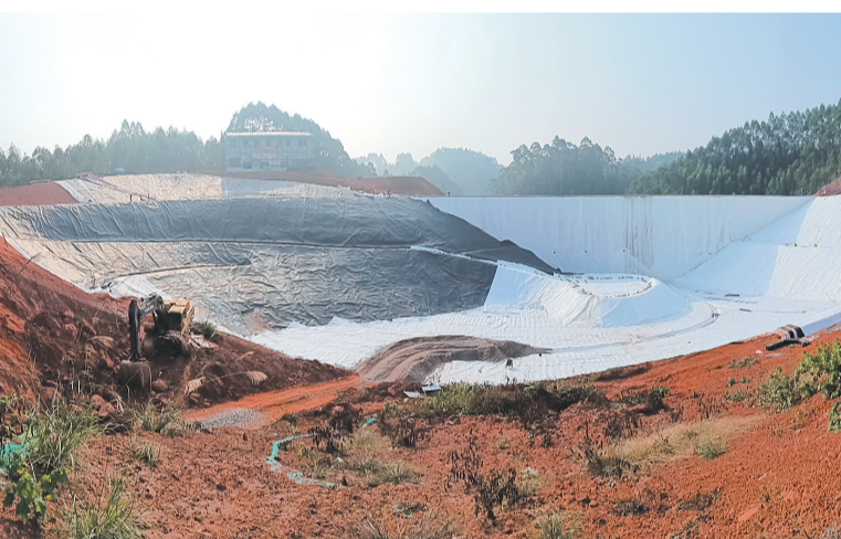
项目建设现场
