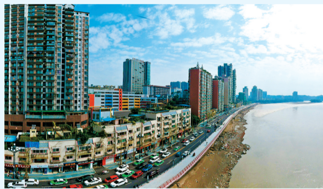
乐山中心城区滨河路防洪能力提升综合整治工程
