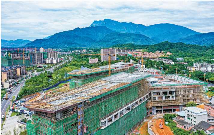
华西医院峨眉分院项目建设现场 李应林 摄
