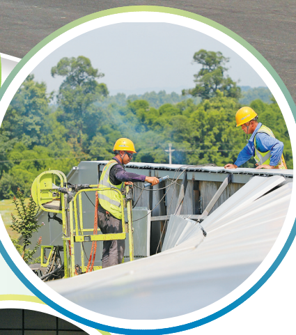
▲施工人员战酷暑赶进度
