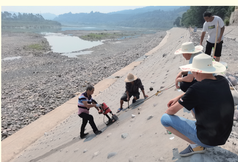
近日,沙湾区审计局在对全区2021重点水利项目专项审计调查中,重点关注项目批复、招投标执行、合同管理、设计变更管理等情况,助力提升水利工程项目质量。 图为审计人员在大渡河左岸葫芦防洪工程现场抽查护坡施工厚度。 张妮 摄
