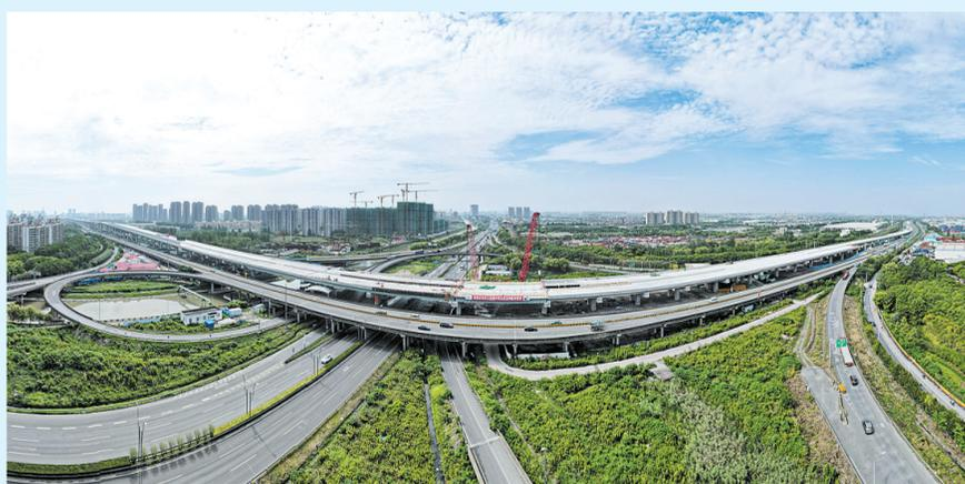
7月20日,上海市沿江通道浦西接线段(下称“浦西段”)工程最后一跨主线桥梁上部结构完成吊装,提前40天实现沿江通道浦西段7.8公里高速主线桥梁结构贯通节点目标。沿江通道浦西段高速主线也将于年内实现通车。
