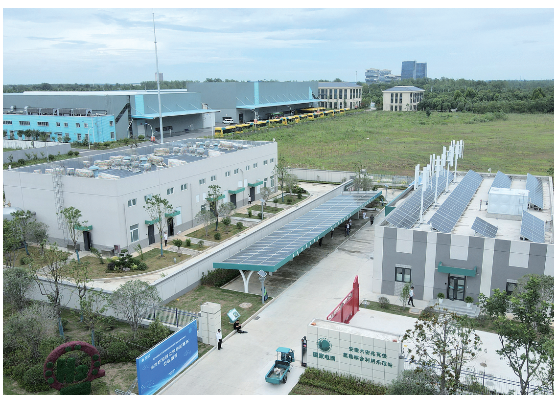
7月6日,国内首座兆瓦级氢能综合利用示范站在安徽六安投运,标志着我国首次实现兆瓦级制氢—储氢—氢能发电的全链条技术贯通。 图为当日拍摄的安徽六安兆瓦级氢能综合利用示范站(无人机照片)。
