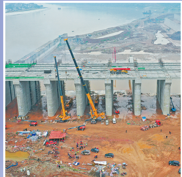
岷江龙溪口航电枢纽工程右岸11孔泄洪闸预制梁安装完成 中交四航局 供图
