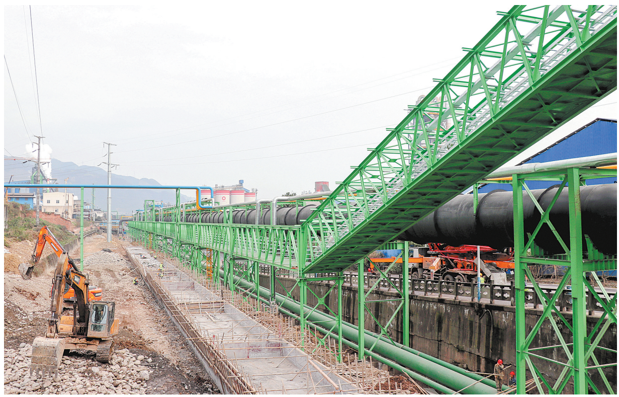
德胜钒钛技改综合管廊项目建设现场
