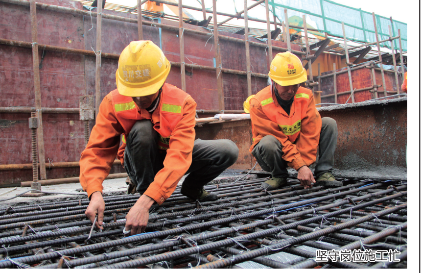
坚守岗位施工
