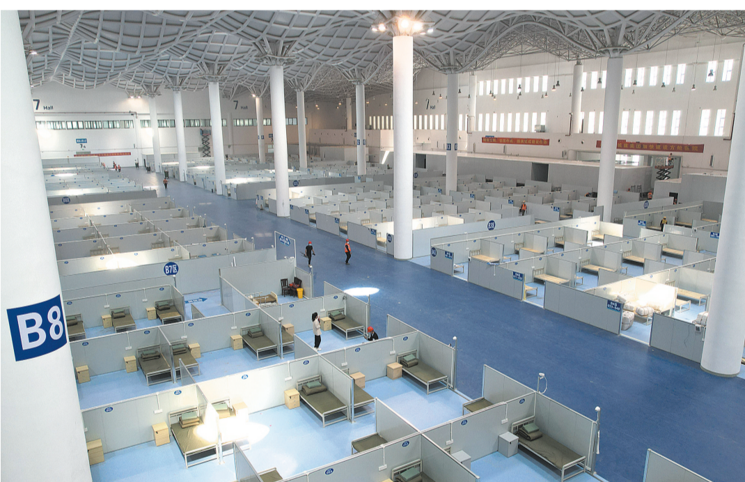
近日,选址在海南国际会展中心的海口方舱医院建设工作加紧推进。据了解,该方舱医院可提供约2000张床位,配套建设可供485名医务人员和320名后勤保障人员使用的工作和生活系统。方舱医院基础设施建设将于4月8日建成,确保接到使用指令后2天内能快速投入使用。图为4月6日拍摄的海南国际会展中心内的海口方舱医院(无人机照片)。
