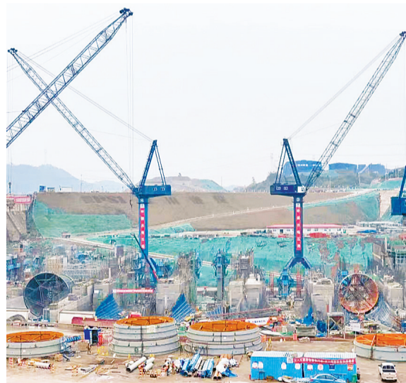
岷江龙溪口航电枢纽工程抓紧施工 键为县融媒体中心 供图
