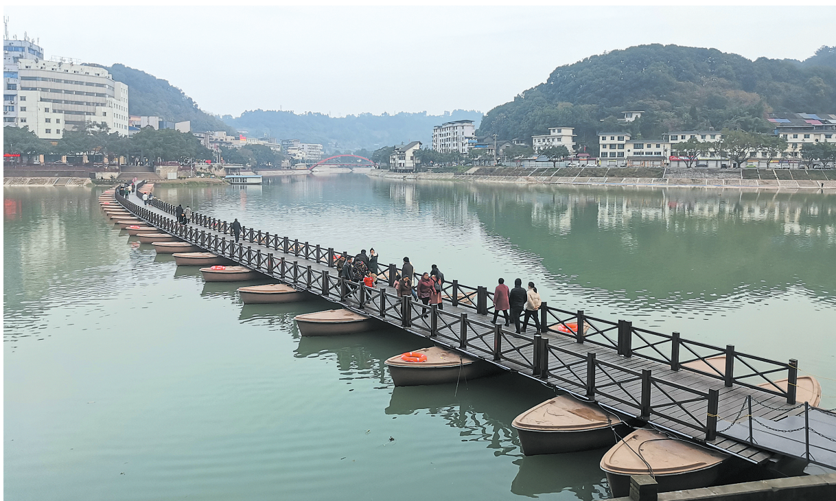
经过维修的五通桥浮桥
