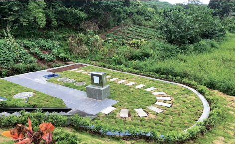
井研县农村生活污水集中处理设施 井研生态环境局 供图
