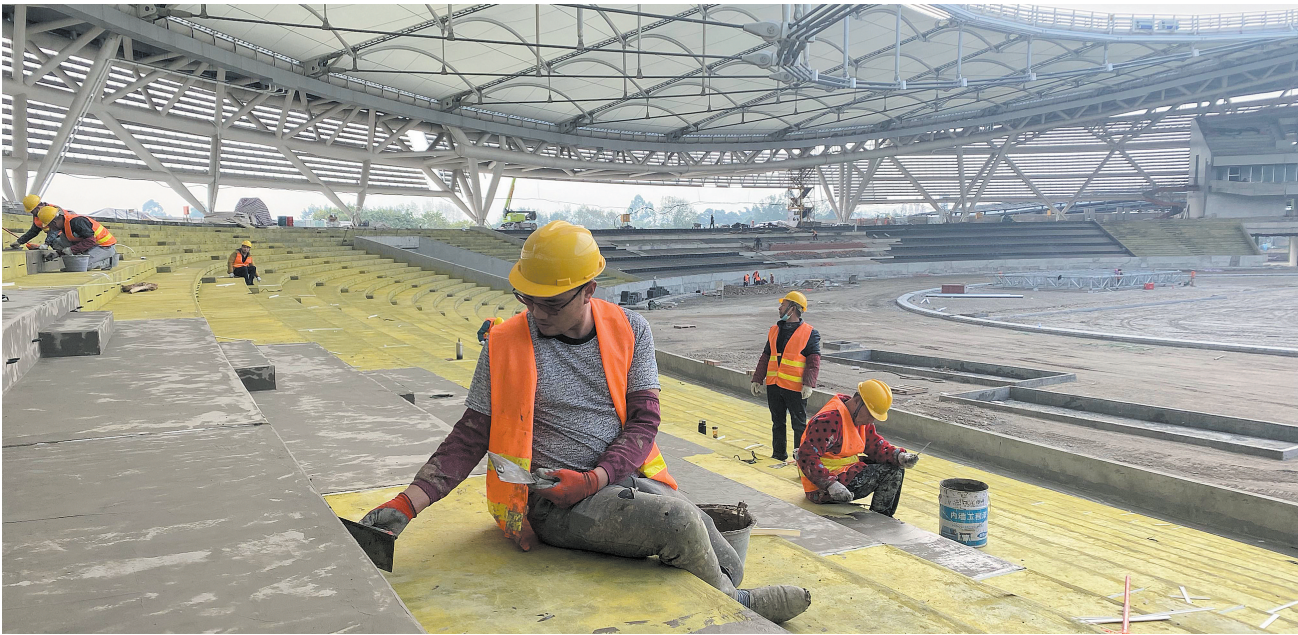
抓紧场馆室内装修
