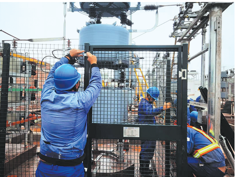
施工人员进行设备安装
