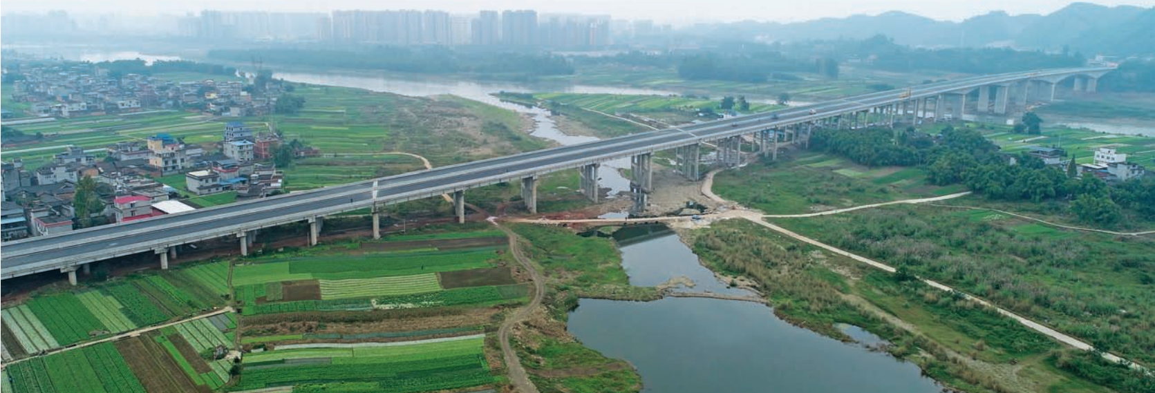
漩水沱岷江特大桥已完工
