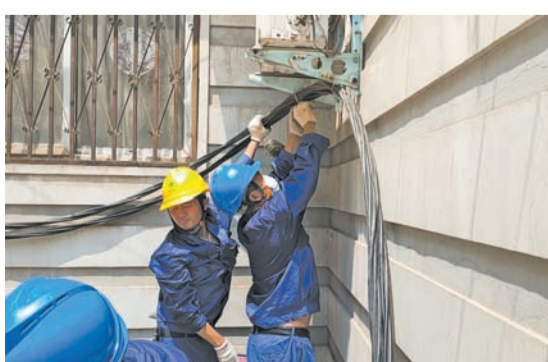
固定临时供电线缆
