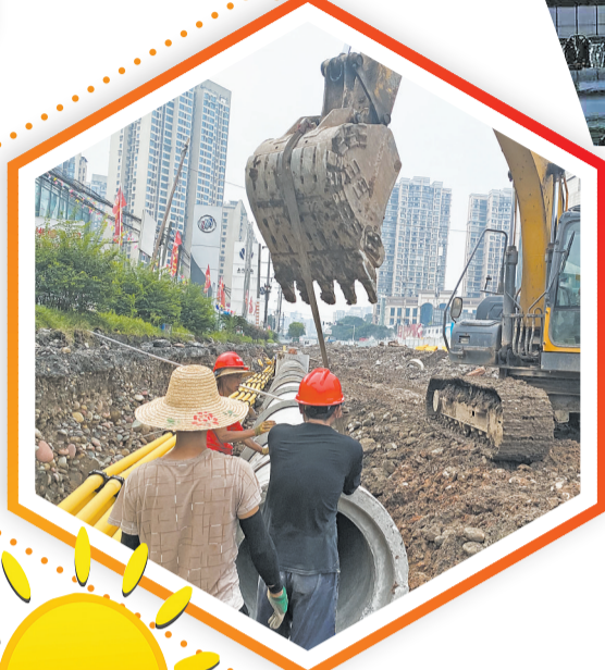
施工人员推进项目建设 记者 何思源 摄
