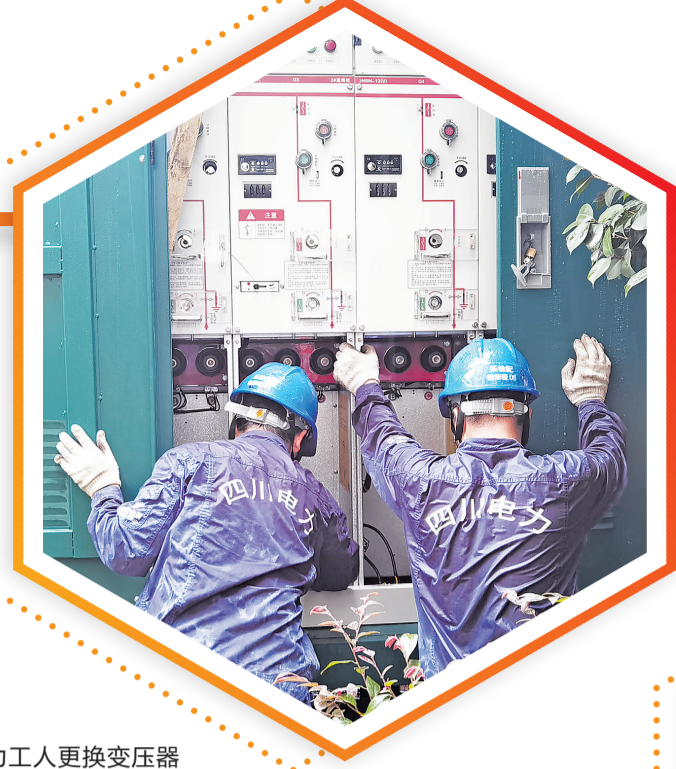
电力工人更换变压器 记者 何思源 摄
