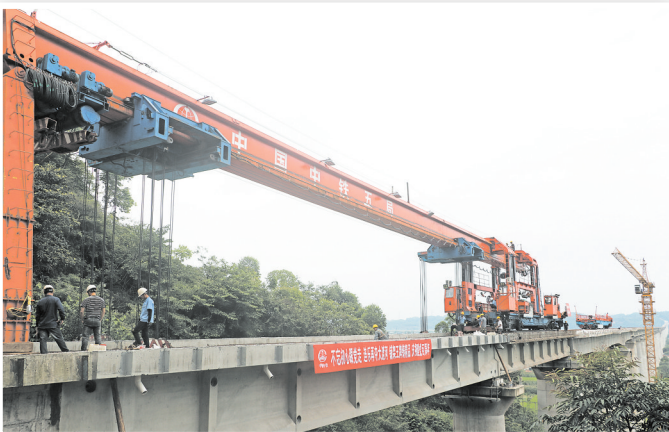
连乐铁路沙湾大渡河特大桥贯通 中铁五局六公司连乐铁路项目部 供图
