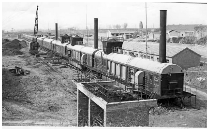
国产6000千瓦的列车电站
