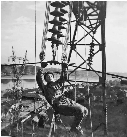
上世纪70年代乐山电力工人带电作业更换直线串绝缘子
