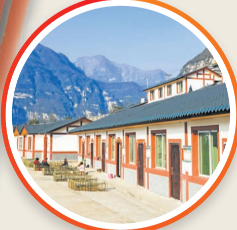
永和镇新华村易地扶贫集中安置点
