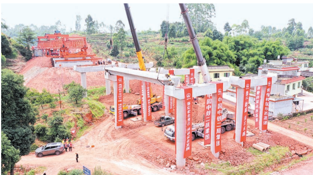
首片预制梁架设现场
