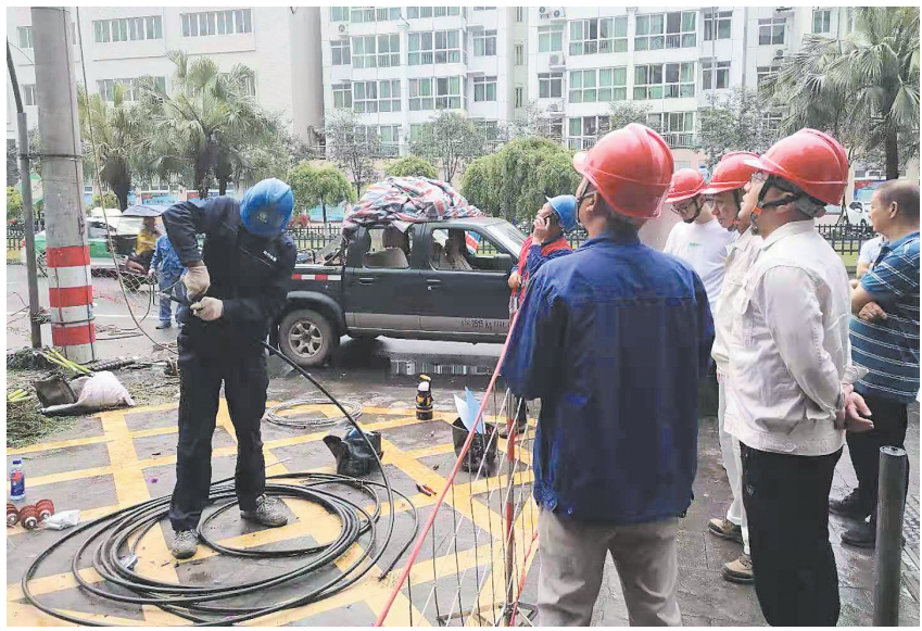
电力人员抢修电路
