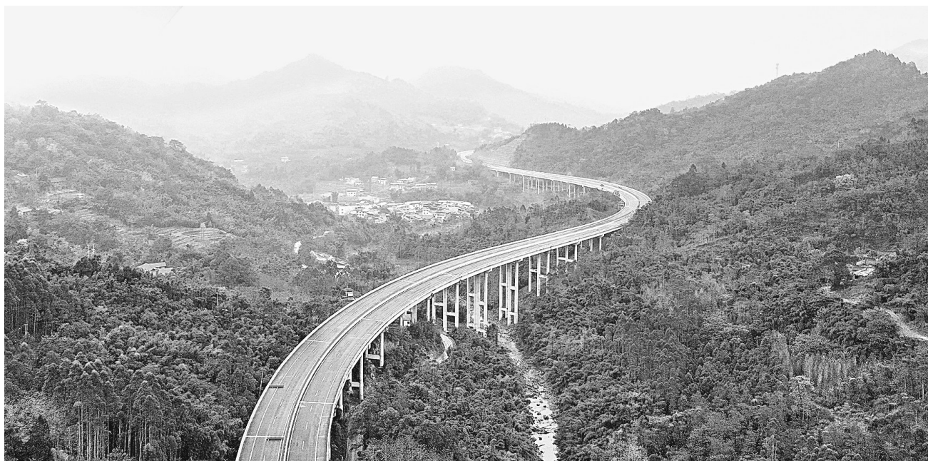
仁沐新高速公路石盘特大桥
