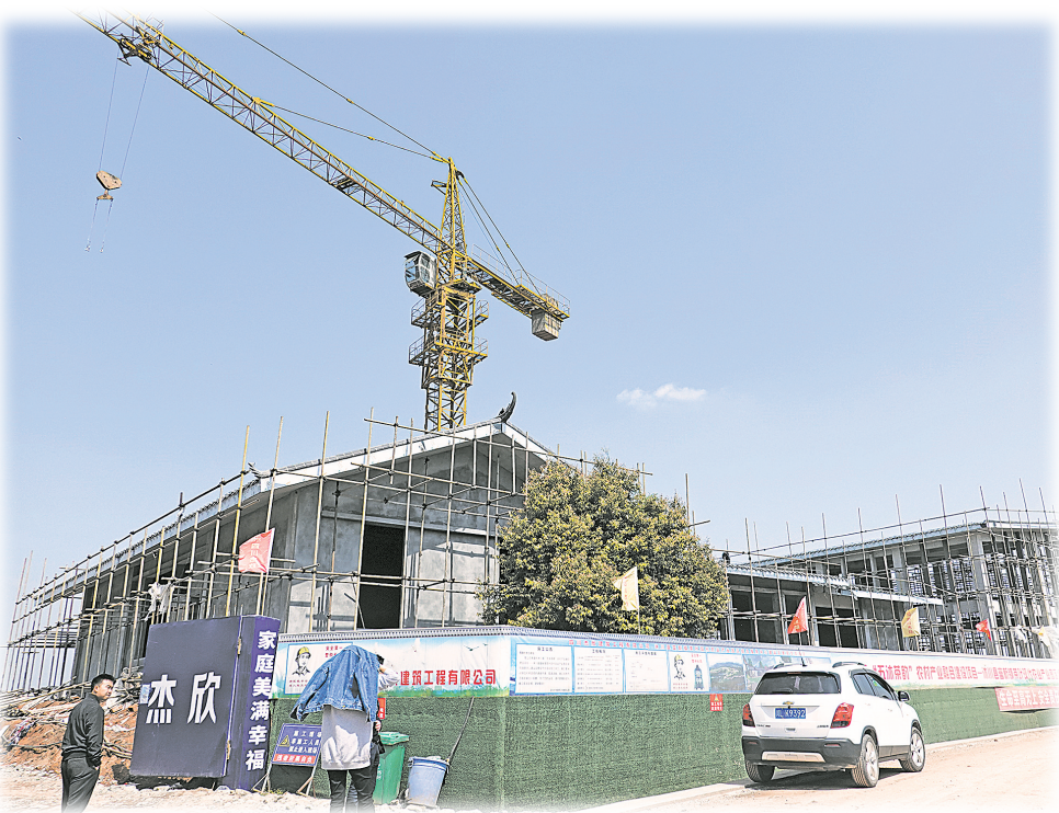
建设中的游客中心
