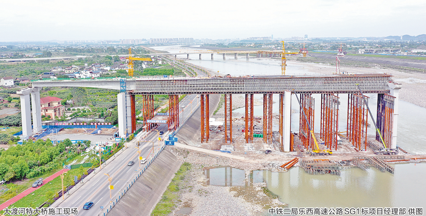
大渡河特大桥施工现场
