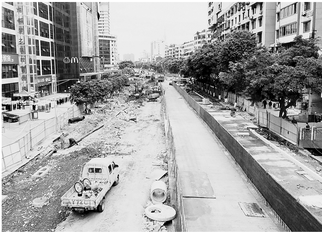
嘉定路二期改造工程全封闭路段已经设置出城方向单向车道
