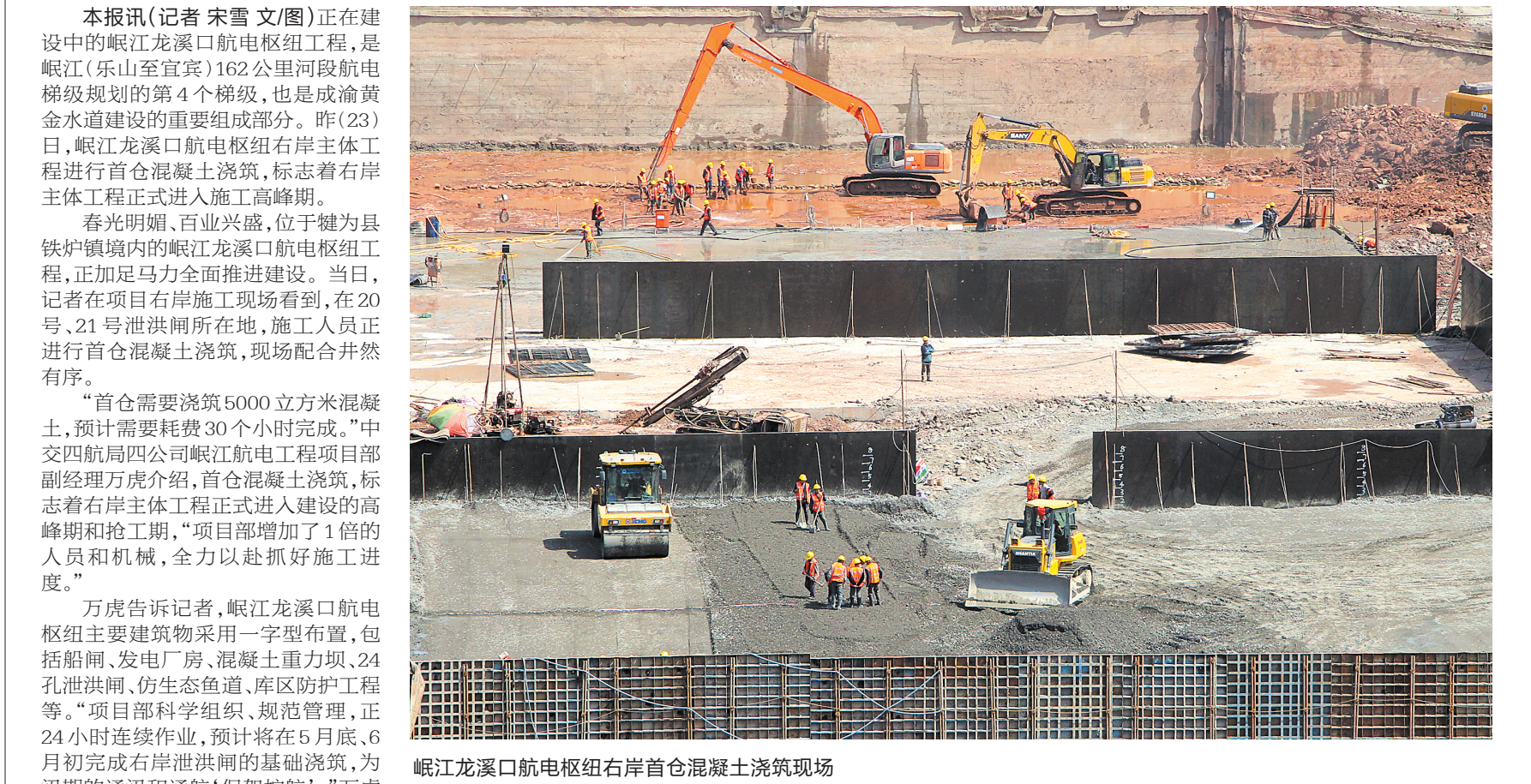
岷江龙溪口航电枢纽右岸首仓混凝土浇筑现场
