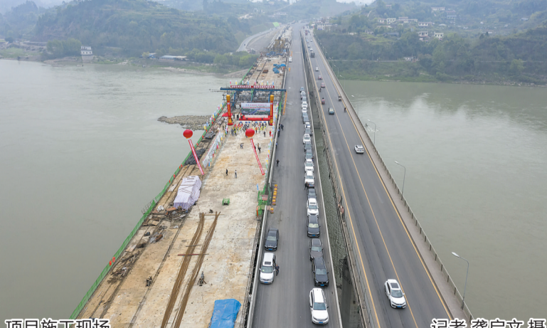
项目施工现场 记者 龚启文 摄
