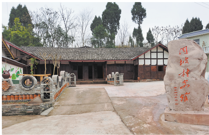
周坡村史馆一景
