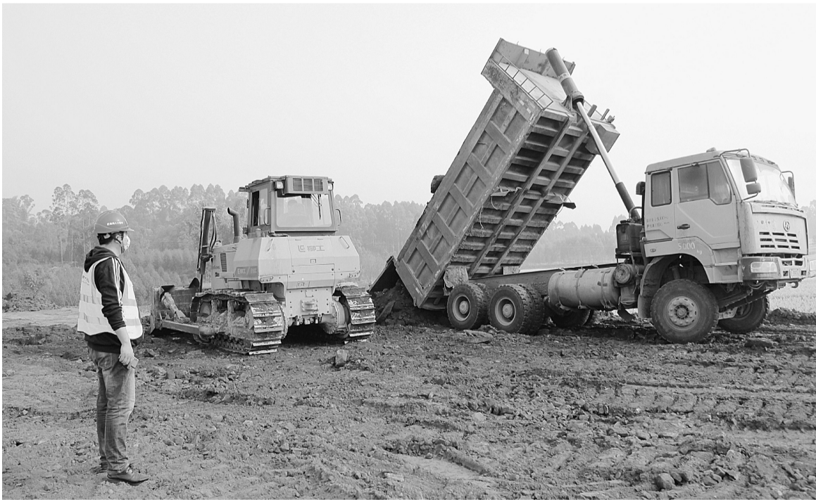
省道215线大件过境公路建设现场
