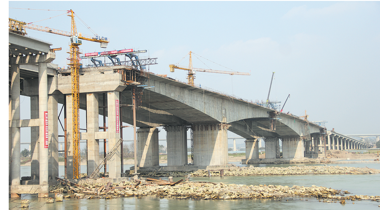
岷江特大桥右幅加快建设
