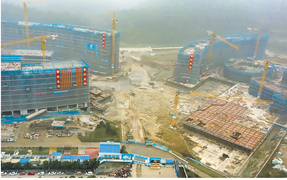
鸟瞰乐山市新区医院施工现场
