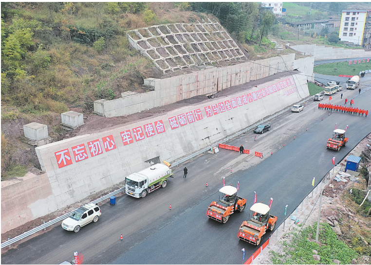
马边支线路面最后一公里油面铺筑完成
