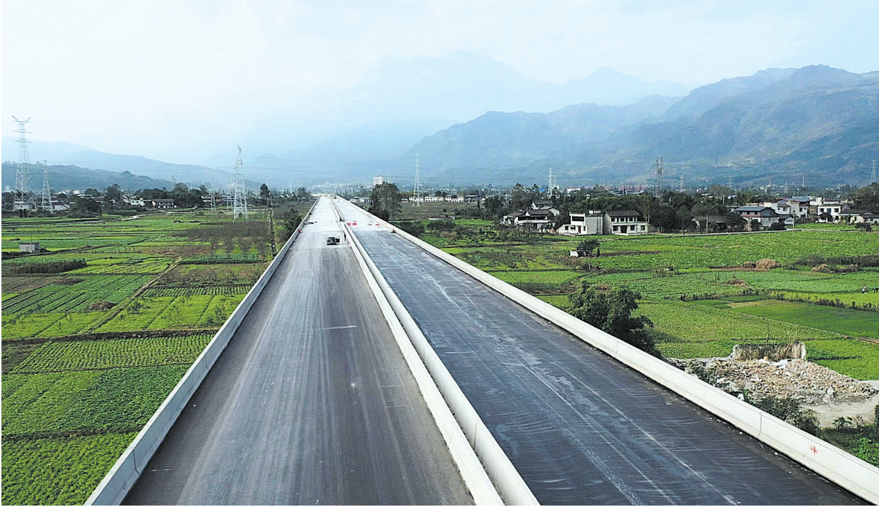
峨眉高架特大桥已全线贯通
