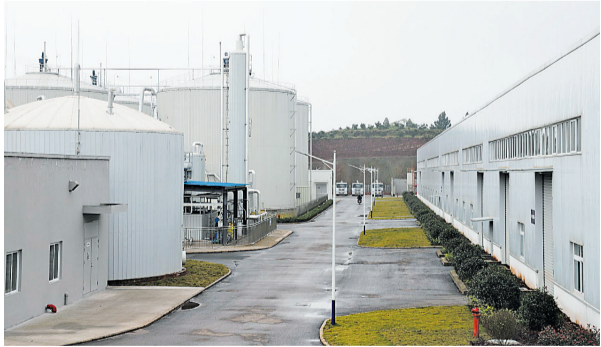
井研县规模化大型沼气工程实现粪污变废为宝,为建设现代农业产业园区提供生态保障和能源支撑。 记者 张斯炜 摄
