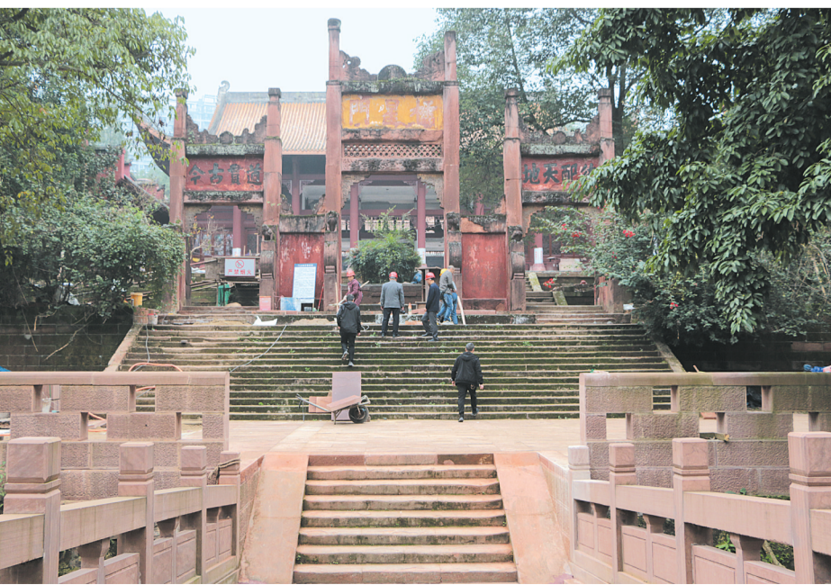
乐山文庙修缮施工抓紧推进
