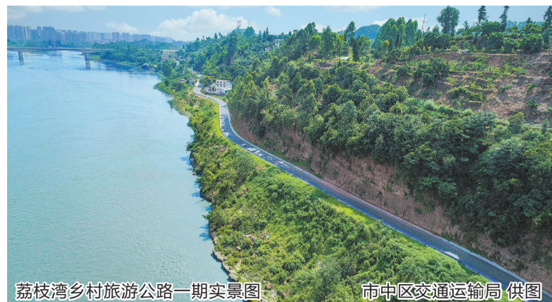
荔枝湾乡村旅游公路一期实景图
