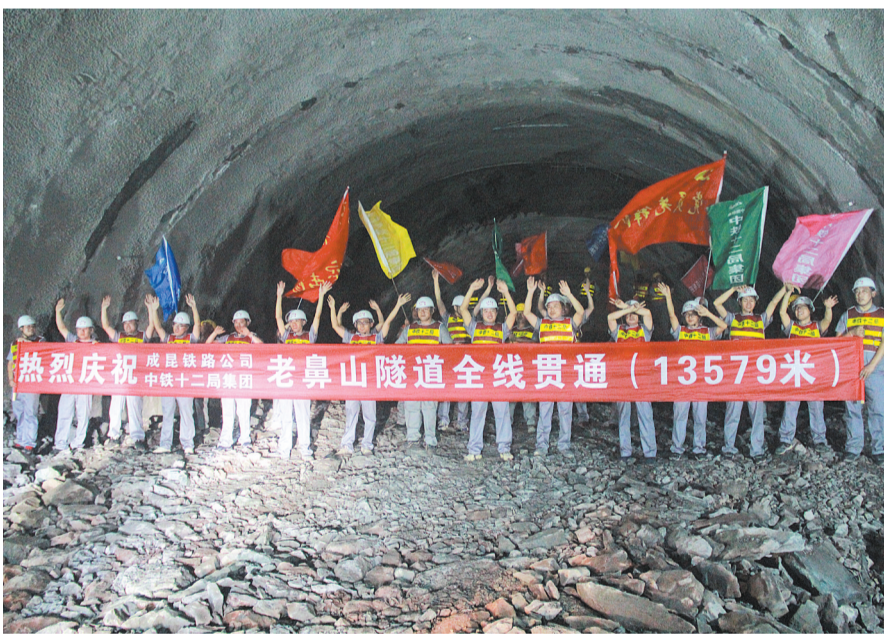
老鼻山隧道全线贯通
