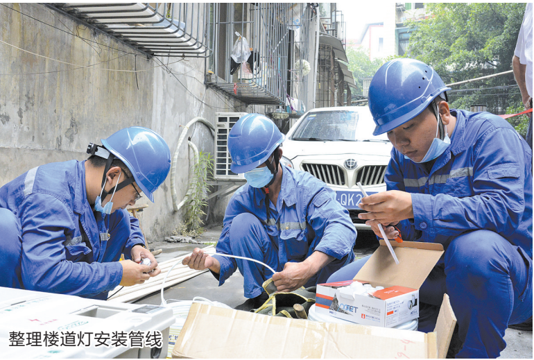
整理楼道灯安装管线
