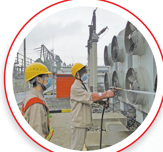
工作人员在220千伏沫水变电站对二号主变进行带电水冲洗
