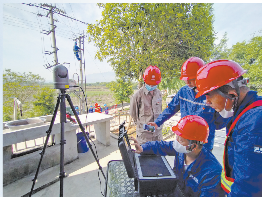
安监人员在10千伏苏临线春季线路检修现场使用远程会商系统开展安全督查
