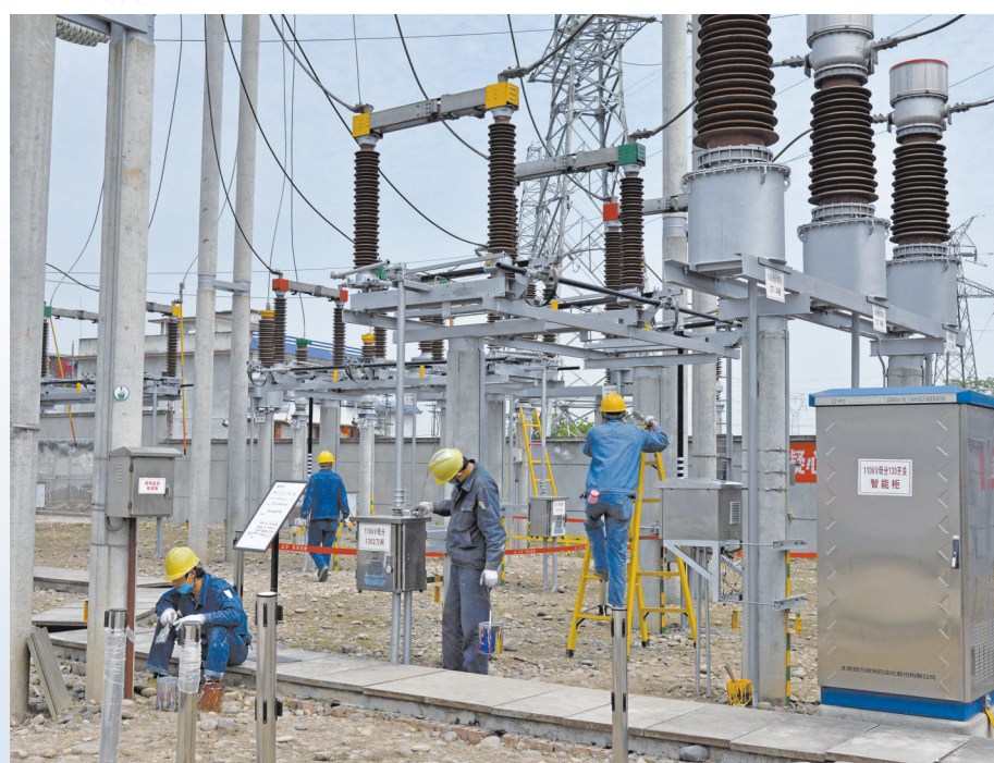
工作人员对设备构架进行防腐刷漆
