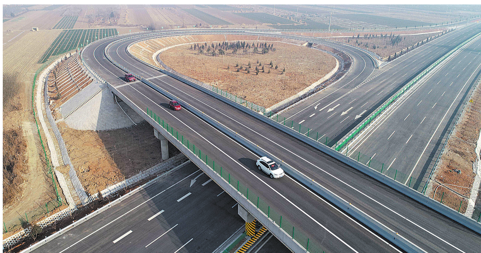
12月16日,京(北京)秦(秦皇岛)高速公路二期工程河北省玉田县大安镇(津冀界)至遵化市平安城路段通车,这标志着从北京东六环到承德(唐山)高速全线贯通,为京津冀三地增加了又一快速连接通道。 据介绍,京秦高速公路河北省大安镇至平安城段西连京秦高速天津段,东连京秦高速公路一期工程清东陵高速公路,全长38.399公里,双向6车道,设计行车时速120公里。 图为无人机拍摄的京秦高速公路二期工程河北玉田西进出口处的立交桥。 新华社记者杨世尧摄
