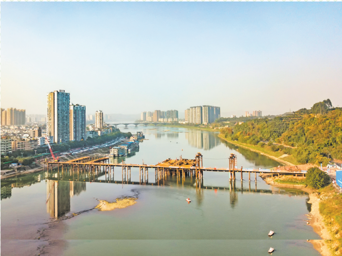
致江路大桥建设有序推进
