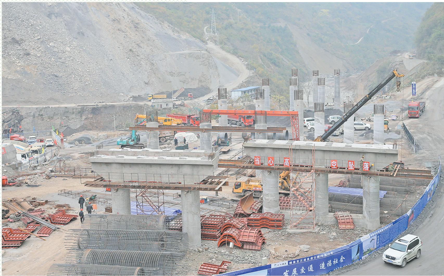
峨汉高速加快建设
