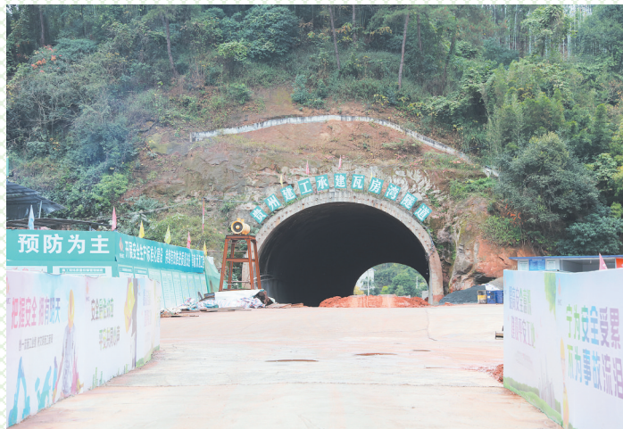
乐山大佛景区猫猫冲至大石桥(S104线复线)瓦房湾隧道抓紧施工
