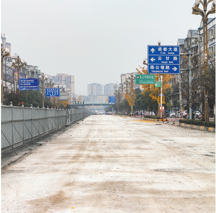
S103线黄士至瀋城段路基施工已全面完成
