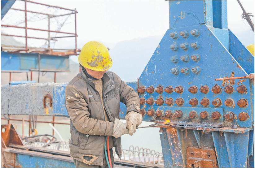
施工人员正在焊接
