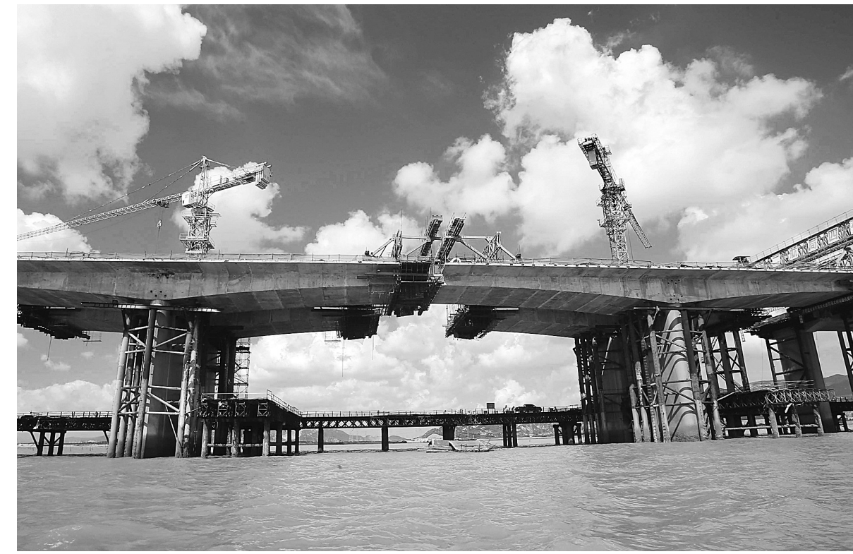
连云港首座跨海大桥起点为连云区高公岛,终点至海滨大道徐圩段,全长4.482公里。该桥有主、辅两个通航孔,主通航孔目前仍在施工中,大桥预计于今年年底贯通。图为9月9日,江苏连云港跨海大桥辅通航孔成功浇筑最后一方混凝土,顺利实现合龙。
